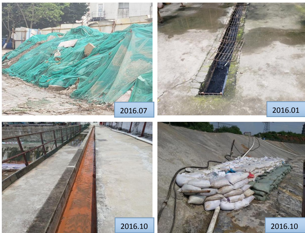
图 3-3 水土保持临时措施照片
