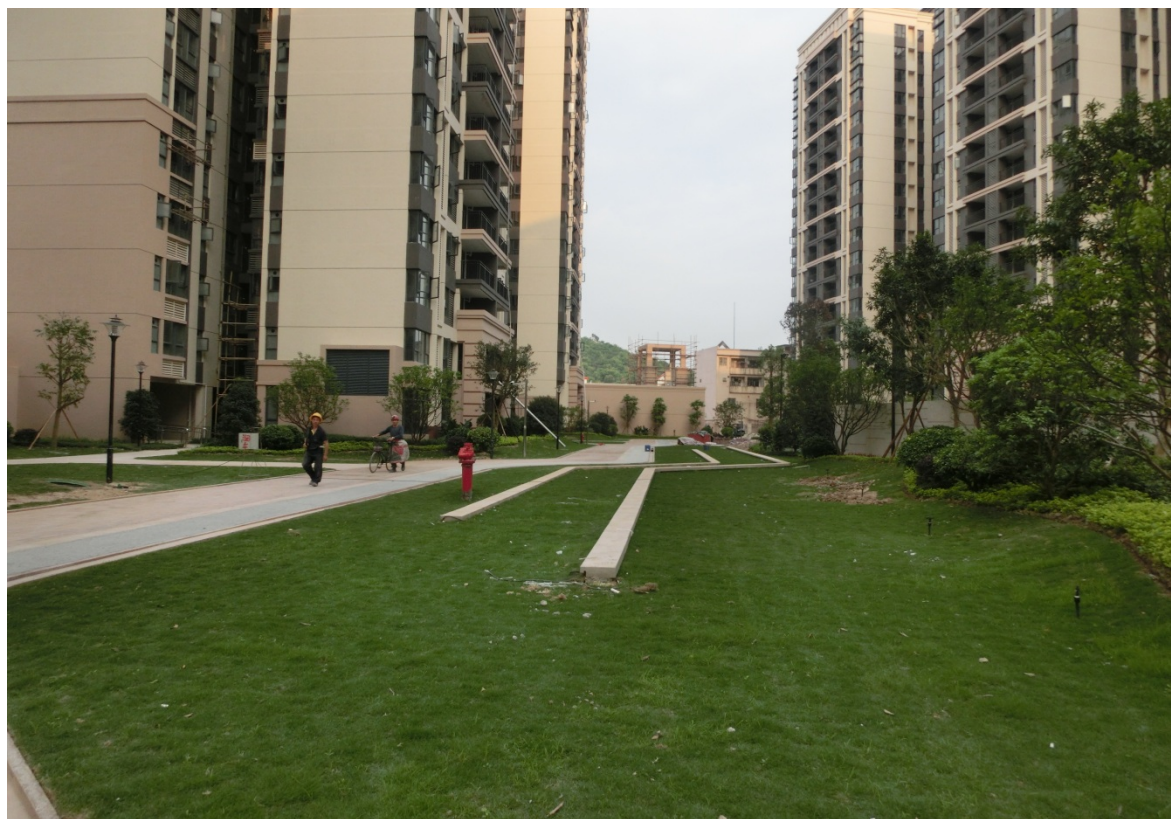
2019 年 4 月 15 日，召开水土保持设施验收会议前现场调查照片
