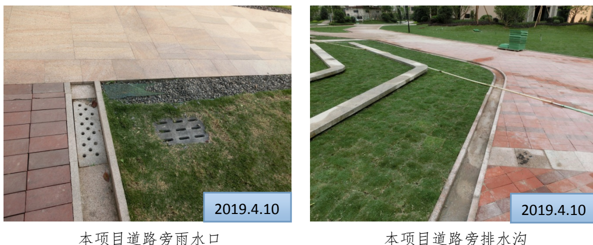
图 3-1 水土保持工程措施照片
